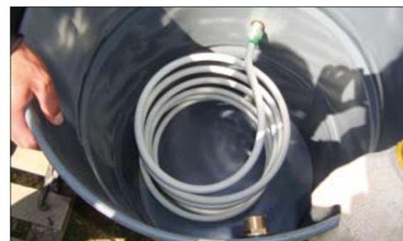
**Шаг 4.** Установите теплообменник в бак. Важно, чтобы спираль теплообменника не имела обратного уклона, то есть начиная сверху было обеспечено беспрепятственное движение жидкости по нисходящей. Поэтому витки спирали в баке желательно раскрепить. Затем укрепите адаптеры.
