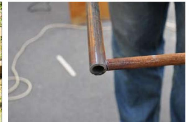
**Шаг 6.** Приварите 8 труб 1/2" к двум трубам 3/4", предварительно вырезав концы труб 1/2" так, чтобы они как можно плотнее прилегали к отверстиям в трубах 3/4" (см. изображение) и закройте каждую из двух труб 3/4" с одной стороны металлической заглушкой. Залейте в трубы полученной «решетки» воду, чтобы убедиться, что она нигде не пропускает.
