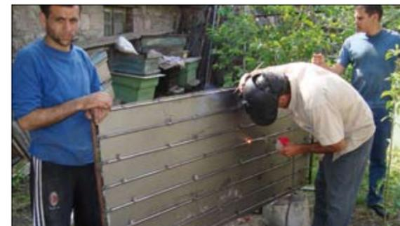
**Шаг 7.** Приварите друг к другу металлический лист и трубы. Трубы 3/4" должны выступать за края металлического листа на 7-10 см одна снизу, другая сверху (схему с размерами см. в Приложении).
