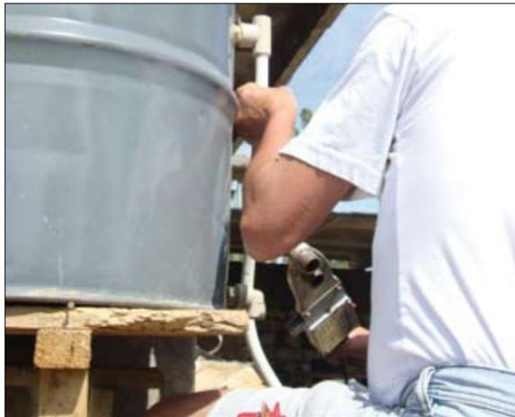
**Шаг 6.** Подсоедините теплообменник к коллектору (выше: вход жидкости, ниже: выход жидкости) и бак к системе водоснабжения. Вход холодной воды из системы водоснабжения (или из дополнительного резервуара) расположен в нижней части бака, а в верхней части бака - выход нагретой воды к потребителю. Установите кран в низшей точке системы, чтобы иметь возможность слить жидкость (антифриз или воду) из системы (см. схему)
