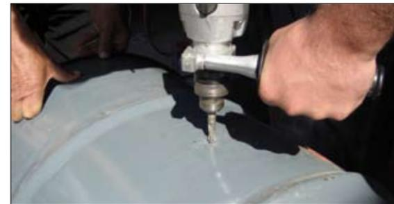
**Шаг 3.** Просверлите в баке два отверстия для присоединения адаптеров теплообменника к трубам ведущим к коллектору и от него, одно выше (вход нагретой в коллекторе жидкости в теплообменник, другое - ниже (выход остывшей жидкости от теплообменника к коллектору). Спираль должна занимать не более чем 2/3 высоты и располагаться в нижней части бака. Просверлите в баке еще два отверстия для воды - одно в верхней части бака и другое в нижней.
