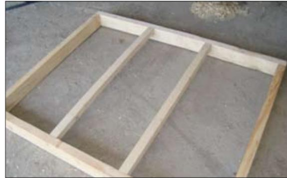
**Шаг 2.** Скрепите между собой стороны брусьев (можно также с помощью металлических уголков)
